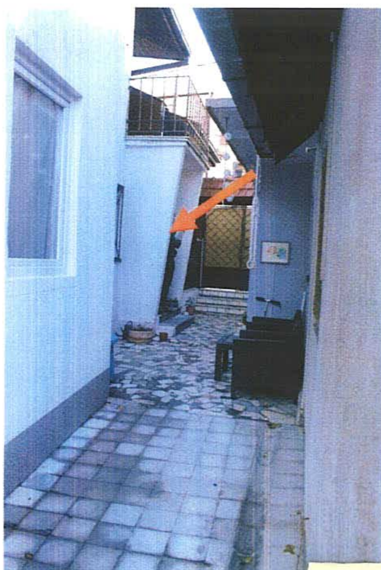
Fotografija broj 5: Prikaz dela zajedničkog dvorišta na parceli broj 3691 K.O. Vračar. Crvenom strelicom označen je ulaz u stan broj 1
